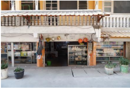
Gambar 8. Perubahan bagian depan rumah penduduk menjadi kios dan toko kelontong Sumber:
