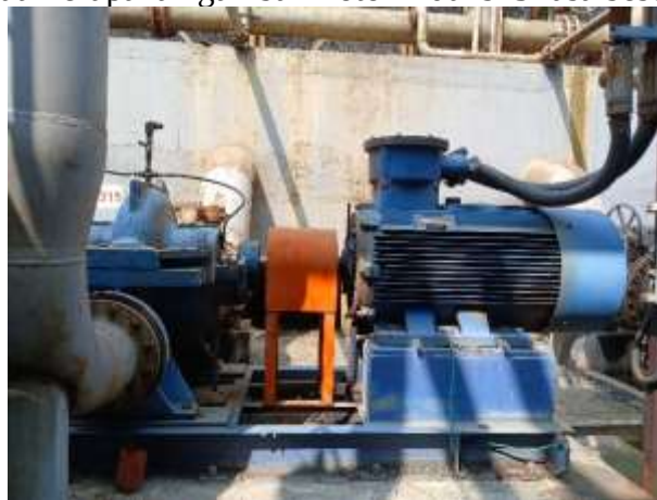
Gambar 2. Motor Induksi 3 Fasa GM-315 A (Sumber: PT. Polychem Indonesia Tbk)
