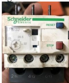
Gambar 8. *Overload Relay* pada panel *press* (Dokumen Pribadi)
