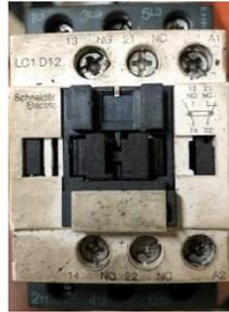
Gambar 7. *Contactor* pada panel *press* (Dokumen Pribadi)
