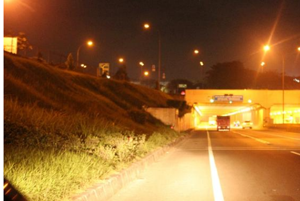
■ Gambar 3. Tampak terowongan Pasar Rebo dua arah yang dipisahkan dengan dinding pemisah.
