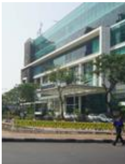
Gambar 6. Bangunan PX Pavillion Sumber: Penulis, 2019
