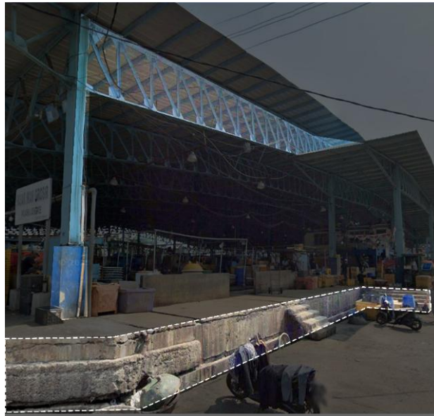
Gambar 4. Penggunaan Sistem Panggung dan Rangka Atap Besi pada Bangunan Pasar Ikan Sumber: Olahan Penulis, 2025
