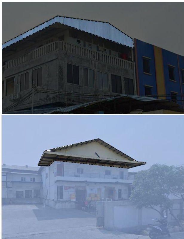
Gambar 5. Penggunaan Struktur Atap Pelana dan Material Besi. Sumber: Olahan Penulis, 2025
