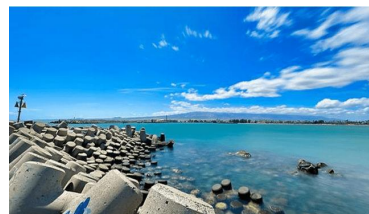
Gambar 16. Pemecah Ombak Sumber: Geosindo, 2022
