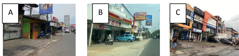
Gambar 16. Kondisi Tipe Bangunan Pada Segmen III
