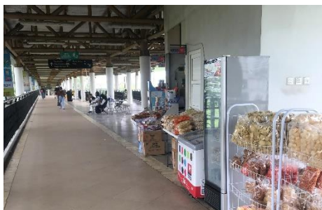
Gambar 14. Kondisi Skybridge Intermoda BSD City Sumber: Dokumentasi Penulis, 2023
