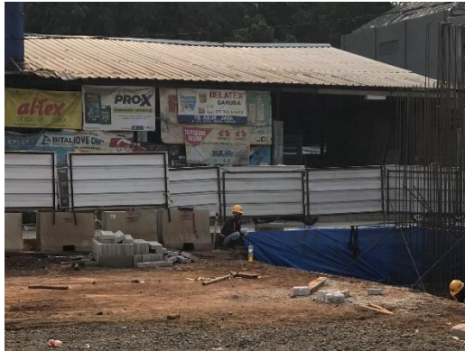
Gambar 8. Proyek Pembangunan Flyover Cisauk Sumber: Dokumentasi Penulis, 2023
