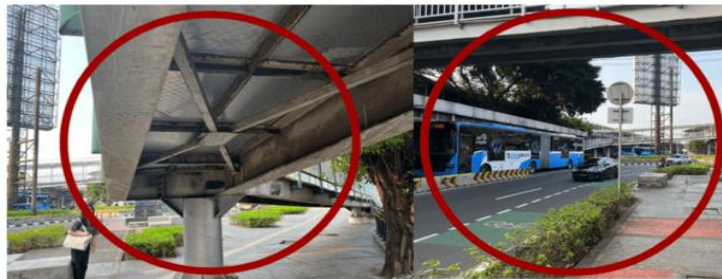
Gambar 14. Dokumentasi sistem struktur JPO eksisting dan jarak bersih dari muka jalanan pada kunjungan tapak. Sumber: Olahan Penulis, 2023
