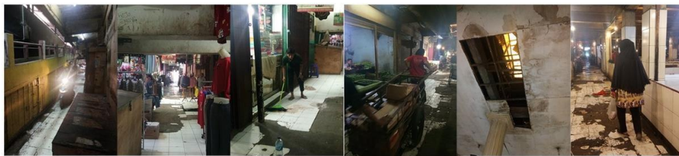
Gambar 1. Kondisi dalam bangunan Pasar Anyar Tangerang. Sumber : Dokumentasi penulis, 2021.
