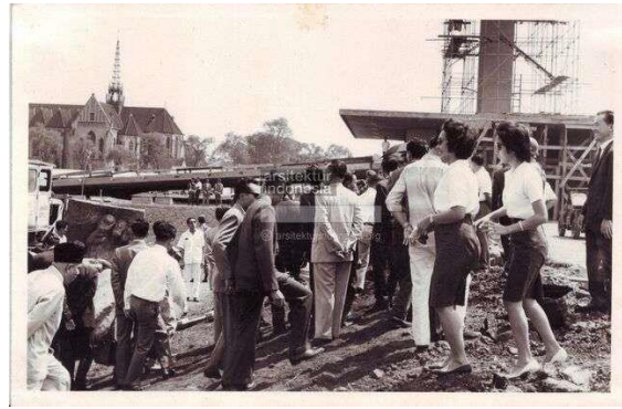
Gambar 11. Foto Proyek Pembangunan Monumen Pembebasan Irian Barat Dengan Latar Gereja Cathedral
