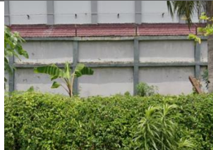
Gambar 26. Tembok Perimeter Pembatas
