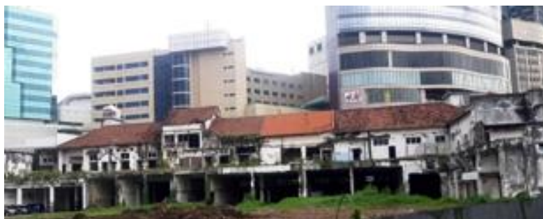
Gambar 6. Kondisi Ekterior Bangunan Lama Sumber: Penulis, 2022
