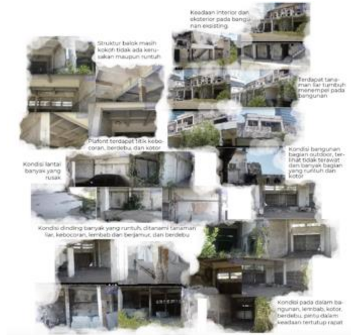
Gambar 5. Analisis Kondisi Eksisting Interior Bangunan Lama Sumber: Penulis, 2022
