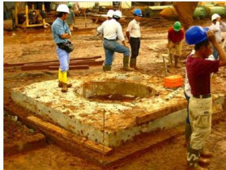
Gambar 7. Gambar platform di lapangan (PT. Indonesia Pondasi Raya)
