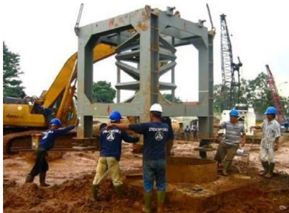
Gambar 8. Gambar platform di lapangan (PT. Indonesia Pondasi Raya)
