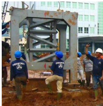
Gambar 13. Gambar peletakan meja besi di atas platform (PT. Indonesia Pondasi Raya)
