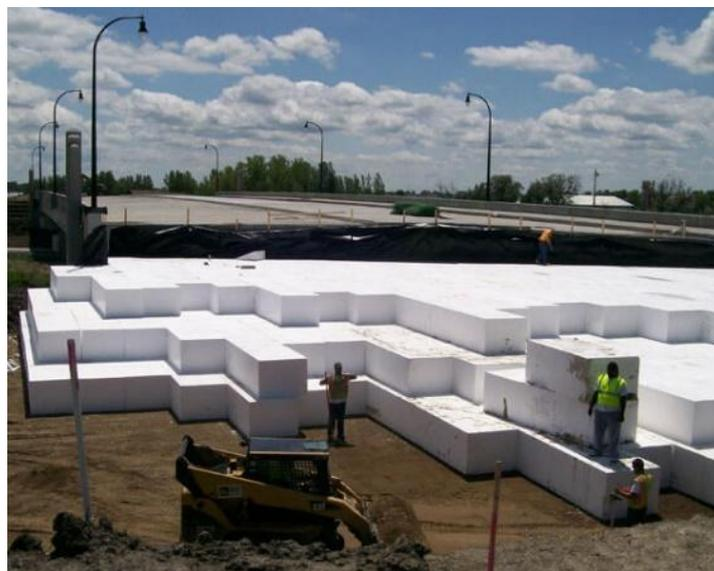
Gambar 1. Bentuk material EPS *geofom* (Geofom Research Center, 2011)
