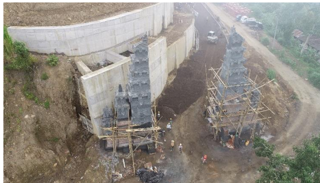
Gambar 3. DPT kantilever pada proyek Tower Turyapada Bali
