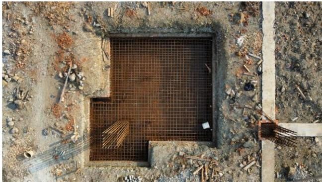
Gambar 1. Tampak pekerjaan *pile cap* struktur *lift* di lapangan
