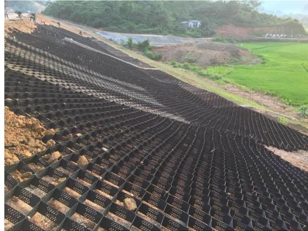
Gambar 2. Penerapan *geocell* sebagai perkuataan lereng
