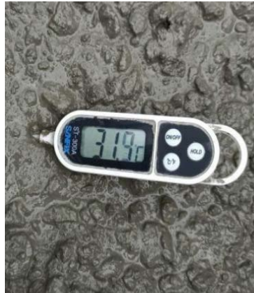
Gambar 3. Pengukuran suhu pada beton
