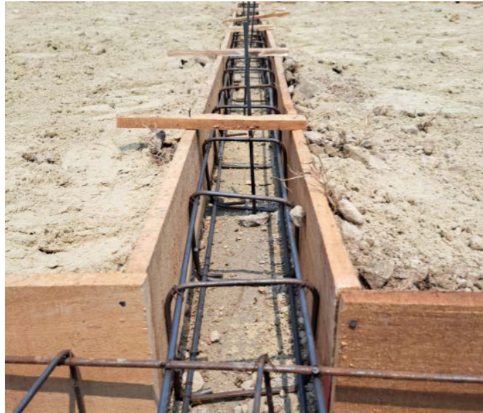
Gambar 2. Gambar pembesian dan bekisting sloof
