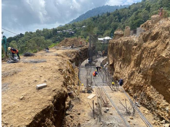
Gambar 7. Pembesian *Pile Cap* oleh pekerja
