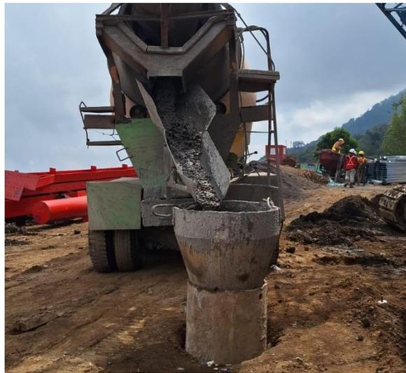
Gambar 4. Pengecoran dengan *mixer truck*
