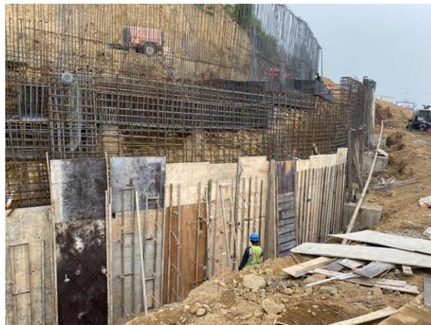
Gambar 10. Pemasangan bekisting pada dinding vertikal
