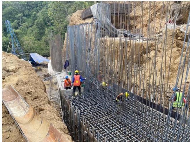
Gambar 8. Pemasangan bekisting pada sisi *pile cap*
