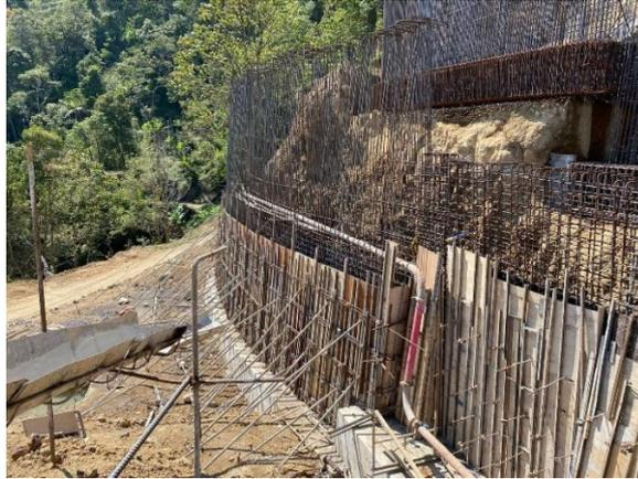
Gambar 11. Pengecoran dinding vertikal
