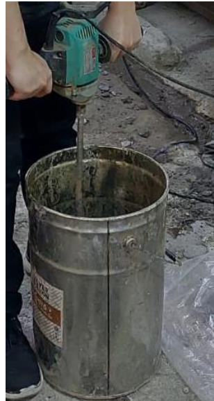
Gambar 2. Proses pembuatan beton geopolimer
