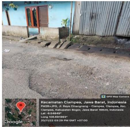
Gambar 4. Tipe Kerusakan Lubang pada Perkerasan Aspal
