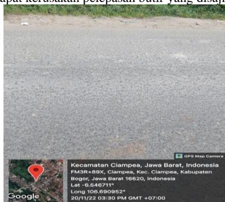
Gambar 3. Tipe Kerusakan Pelapasan Butir pada Perkerasan Aspal
