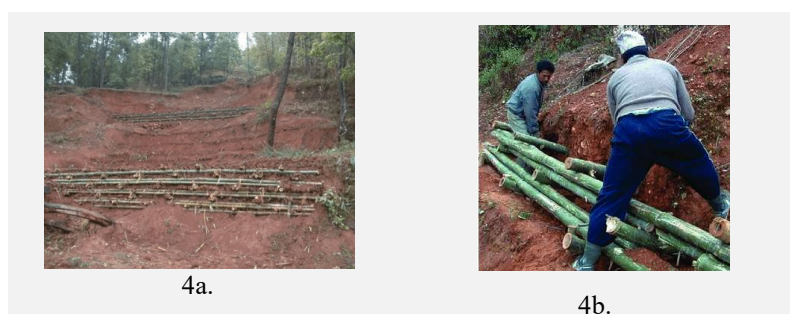
Gambar 4a. Perkuatan Bamboo Crib Wall di Nepal (Tardio et al., 2018)
