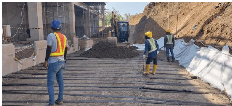
Gambar 12. Pemasangan GI-Strip
