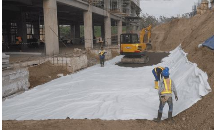
Gambar 11. Pemasangan Geotekstil pada timbunan
