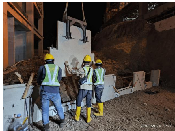
Gambar 10. Pemasangan set panel pertama
