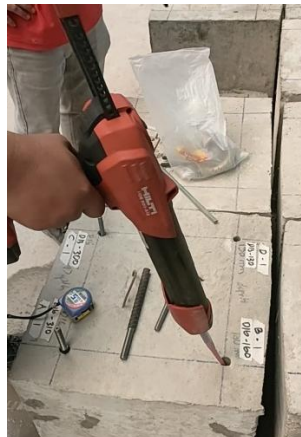
Gambar 6. Proses injeksi chemical ke dalam lubang yang sudah dibersihkan
