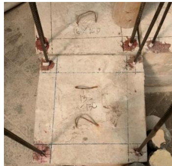
Gambar 8. Angkur yang sudah diinstal pada sampel beton
