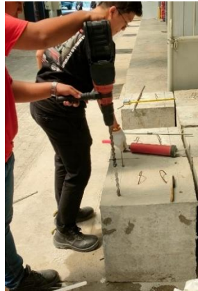
Gambar 4. Proses pengeboran lubang pada titik yang sudah di marking
