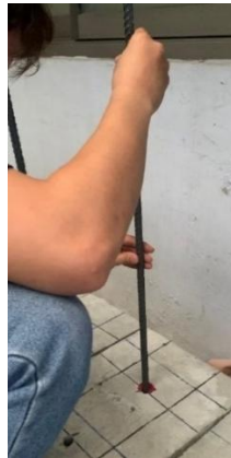
Gambar 7. Proses instalasi angkur ke dalam lubang bor
