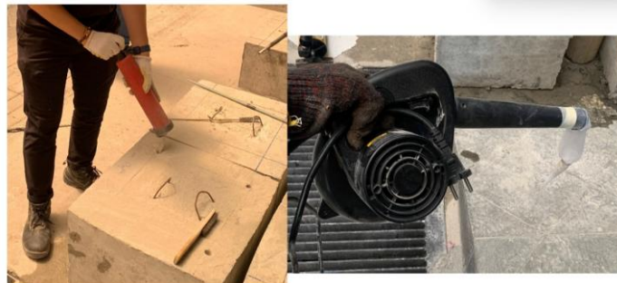
Gambar 5. Pembersihan lubang bor dengan blower dan blowout pump
