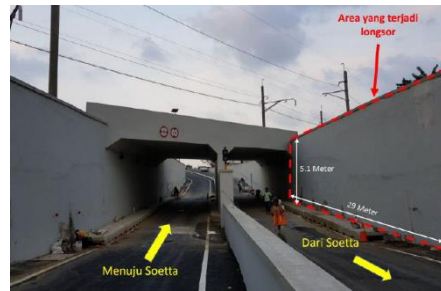
Gambar 2. Lokasi Underpass Sebelum Longsor (Kementerian Pekerjaan Umum dan Perumahan Direktorat Jenderal Bina Marga, 2018)
