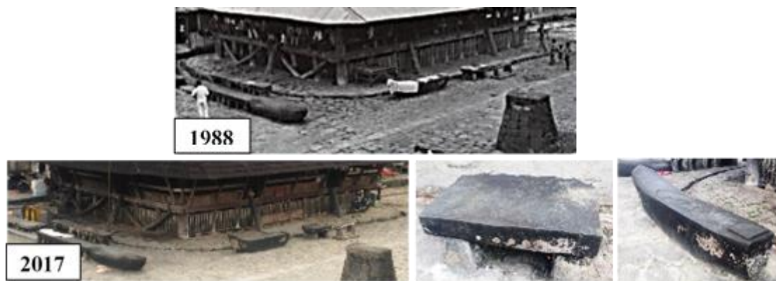
Gambar 8. Kondisi Batu Megalit di Depan Omo Bale yang Mengalami Pelapukan Sumber : Observasi Lapangan dan Hasil Olahan Penulis
