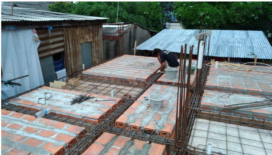
Gambar 5. Balok Keraton yang berfungsi sebagai bekisting pelat sebelum dicor bagian atasnya
