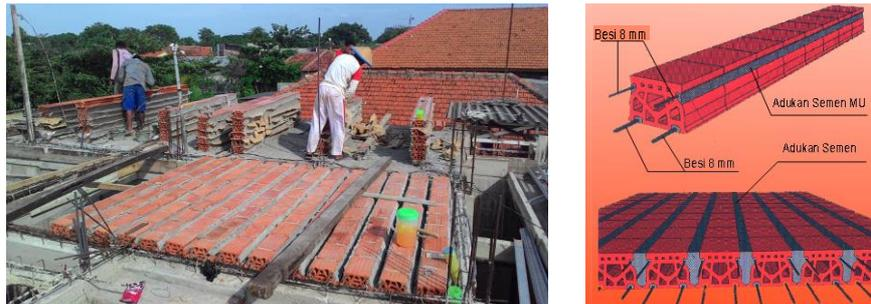
Gambar 2. Pemasangan Pelat dengan Balok Keraton
