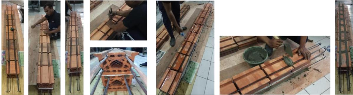
Gambar 4. Proses Pembuatan Balok Keraton
