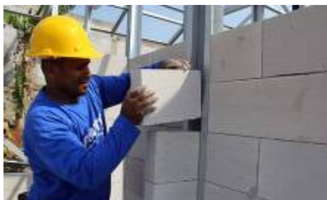
Gambar 3. Dinding DOMUS menggunakan bata ringan
