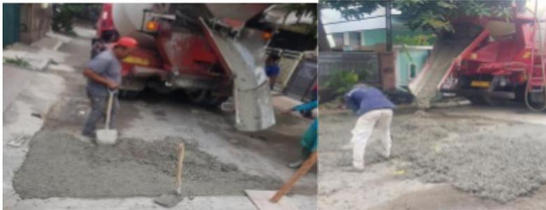
Dengan peralatan sekop, cangkul sendok semen dan pemadat, adonan *pervious concrete* diratakan ke seluruh permukaan jalan yang diperbaiki sehingga terlihat rapi seperti diperlihatkan pada gambar 5.
