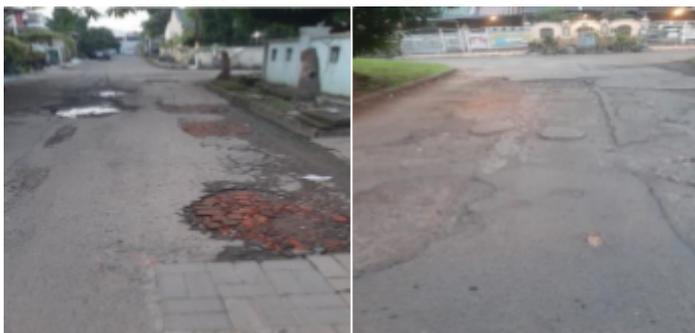
Beberapa usaha perbaikan yang dilakukan oleh warga setempat dilakukan pada beberapa titik dengan jalan menutup lubang menggunakan *paving block* seperti yang diperlihatkan pada gambar 2. atau sebagian warga secara swadaya melakukan pengaspalan pada bagian depan rumah.
