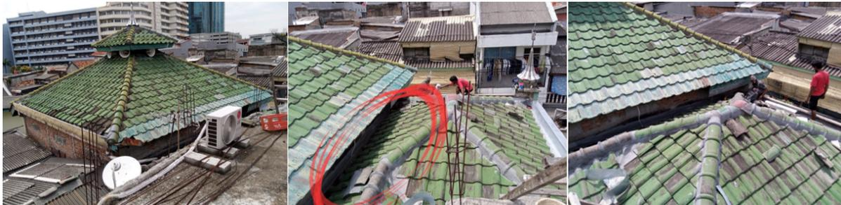
Dampak dari permasalahan struktur luar adalah adanya degradasi struktur pada ruang dalam, diantaranya kebocoran, karat pada elemen struktur, dan lendutan pada kayu (gambar 3). Hal ini mengakibatkan ruang dalam tidak bisa dimanfaatkan untuk aktivitas secara optimal.
