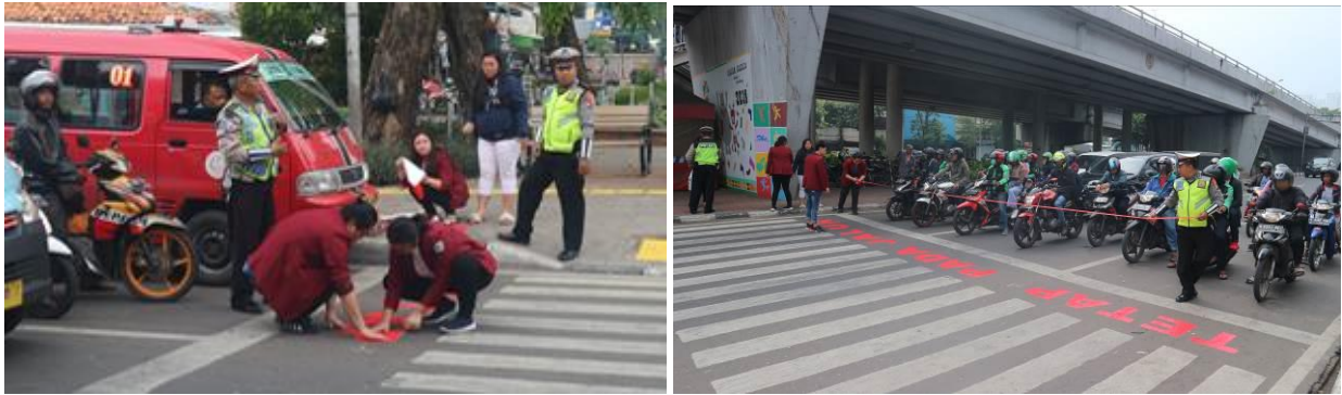
Gambar 10. Proses Pemasangan Rambu Pada Perempatan Jl. Tubagus Angke Sumber: penulis, 2019
