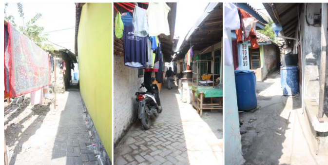
Gambar 5b. Kondisi Jalan gang di Pulau Panggang Sumber: Hasil Survei Tim, 2017
