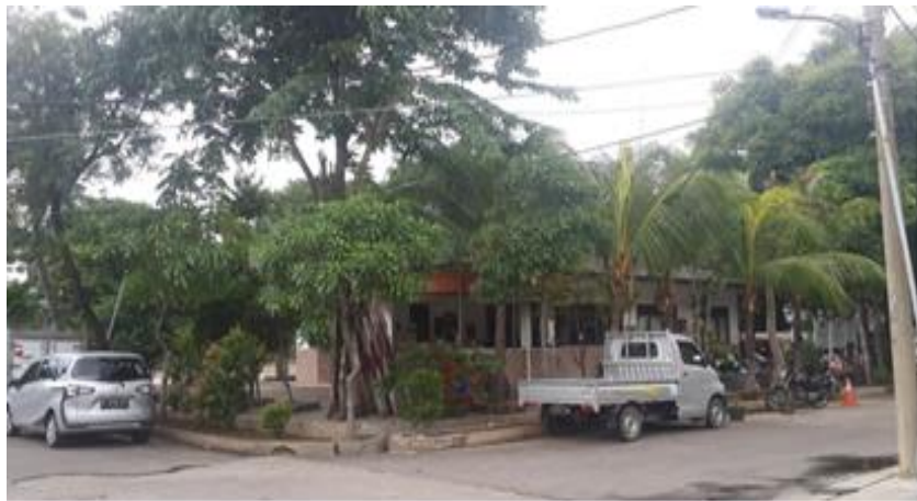
Gambar 1. Bangunan Kantor RW dan vegetasi eksisting dipertahankan.
