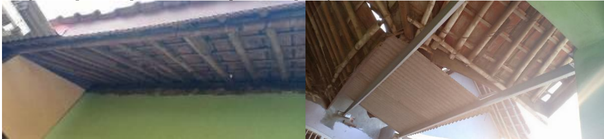
Rangka Atap Terekspos karena Tanpa Penutup Plafon
