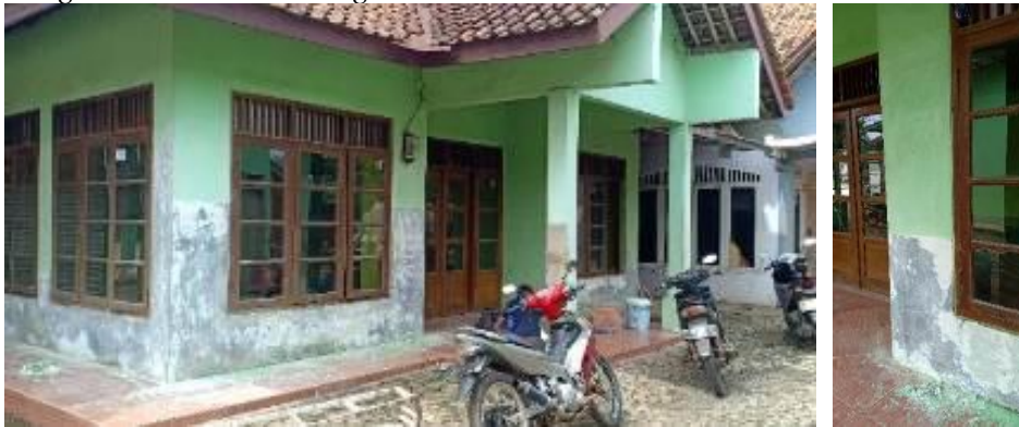
Gambar 7 Pengerokkan Cat Dinding Lama
