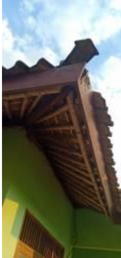
Papan Lisplang dan Genteng yang Rusak pada Sisi Jurai Atap
