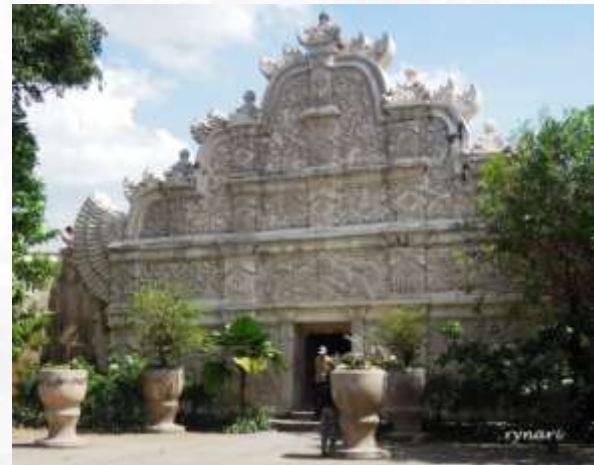
Gambar 10 : Gapura Agung, dengan 4 tingkatan dipertegas oleh hiasan plipit horizontal, juga pilaster sebagai elemen penguat vertikal serta hiasan sayap burung. (Sumber: wisataala.com)
