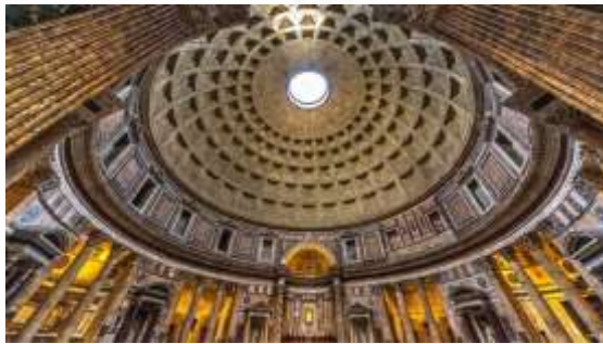
Gambar 9. Kubah Pantheon dengan Permukaan Bermotif Geometris Untuk Mengurangi Beban Kubah (Sumber: https://www.cnnindonesia.com/gaya-hidup/20201123144055-269-573386/pantheon-bangunan-yang-disebut-terkutuk-dan-buatan-iblis )
