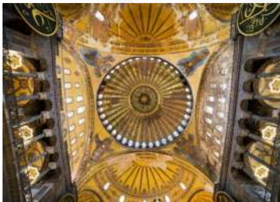
Gambar 10. Kubah Hagia Sophia dengan Pendentives (bidang segitiga cekung) untuk Menyalurkan Beban Kubah (Sumber: https://istanbul.com/id/travel/hagia-sophia-mosque )
