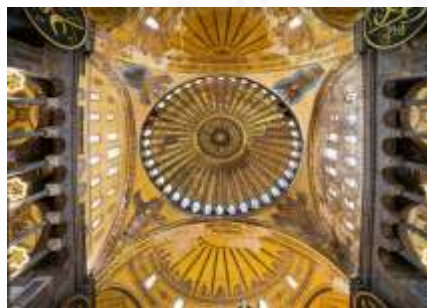
Gambar 13. Lubang Cahaya pada Kubah Hagia Sophia Terletak di Dasar Kubah (Sumber: https://istanbul.com/id/travel/hagia-sophia-mosque )
