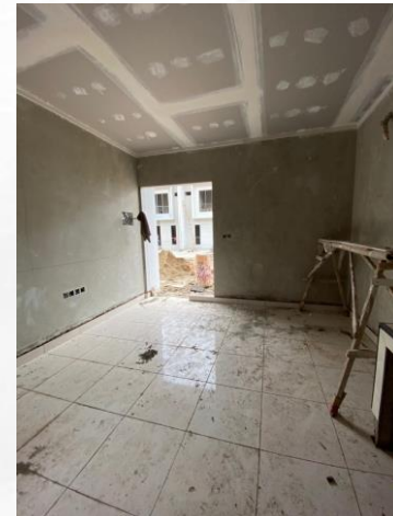
Gambar 4: Bangunan eksisting tempat perancangan ruang keluarga
