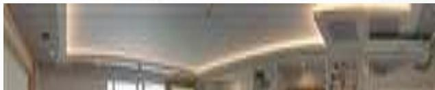
Gambar 19: *Ceiling Treatment* Berupa *Up Ceiling* dan *Drop Ceiling* dengan Lampu *Downlight* dan *Hidden LED Light* (sumber: Penulis)
