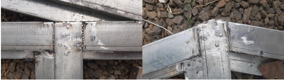
Gambar 2. Sambungan kerangka baja ringan
