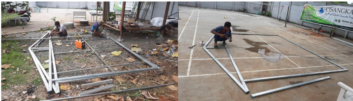
Gambar 3. Kemiringan rangka atap sebesar 15^{\circ} .
