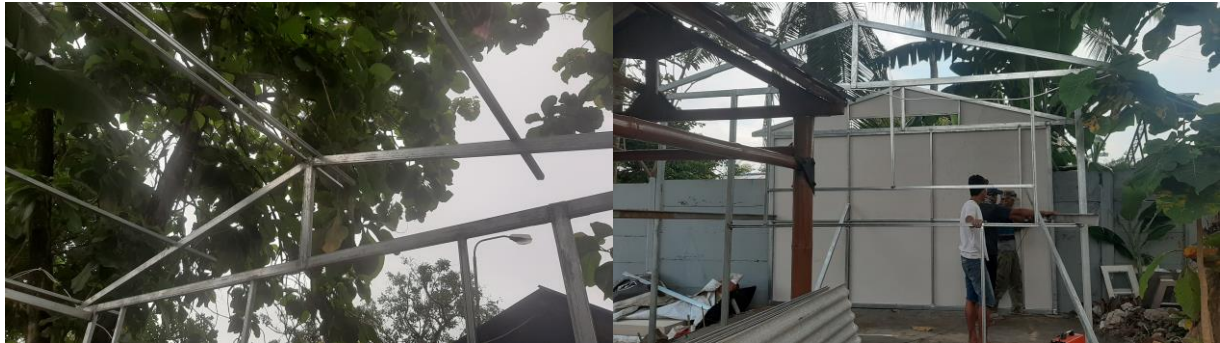
Gambar 5. Pemasangan rangka atap dan bangunan oleh tenaga profesional
