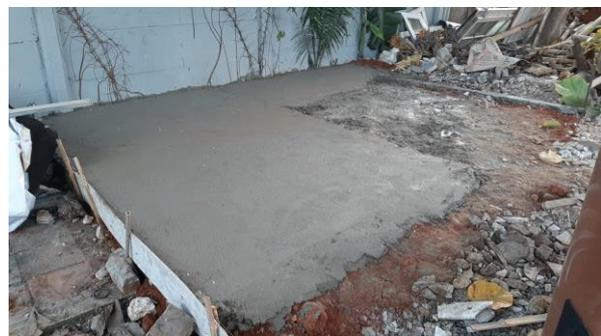
Gambar 4. Pengecoran dasar perpustakaan
