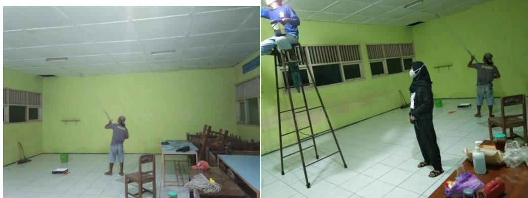
Gambar 5. Tahap pengecatan pada interior Sumber : Penulis, 2022
