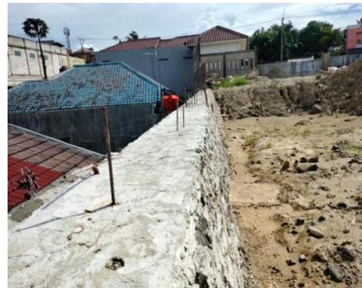
Gambar 5. Dinding penahan tanah yang sudah dibangun pada sesi 4 dilihat dari dalam lahan
