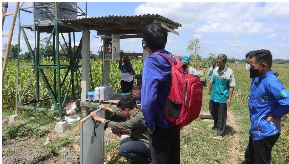
Gambar 5. Bangunan pusat panel kontrol dan tangki air
