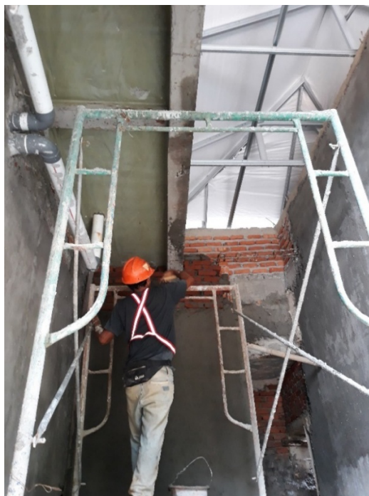
Gambar 3. Pekerja sedang menggunakan scaffolding
