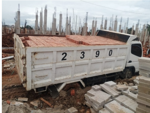
Gambar 2. Kendaraan logistik kesulitan untuk masuk ke area proyek
