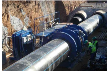
Gambar 5. Pipa PDAM yang sudah terpasang Sumber: Airkami.id
