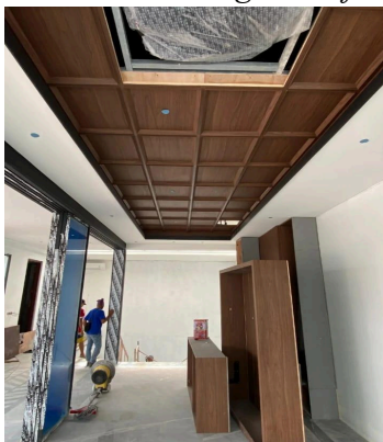
Proses Pemasangan Plafon Interior
