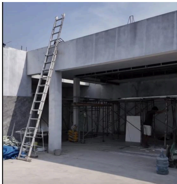
Konstruksi Area Bangunan
