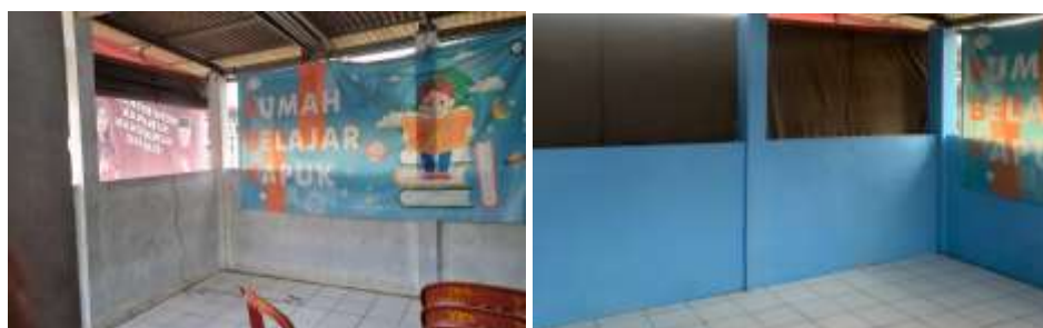
Kondisi Rumah Belajar Kapuk Sebelum dan Sesudah Pengecatan Ulang
